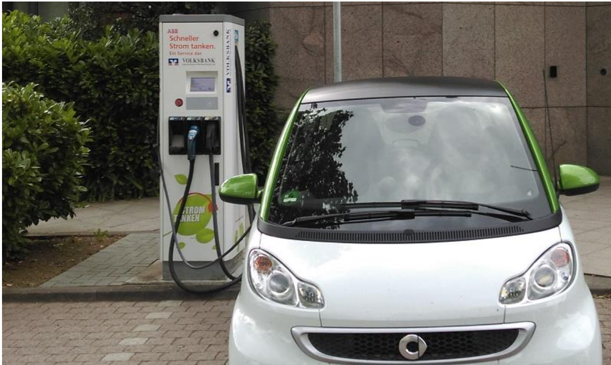
Der Triple-Charger der Volksbank Kaiserslautern, von links nach rechts: AC Typ 2 22 kW, CHAdeMO 30 kW, CCS 30 kW
